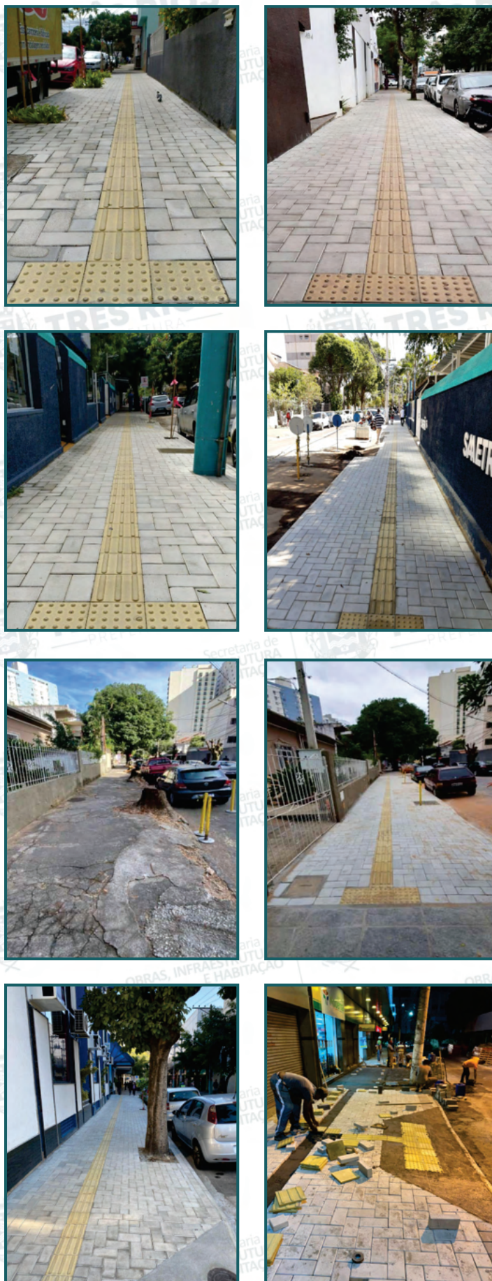
Figura 37. Calçadas Executadas de Maneira Adequada em Três Rios
