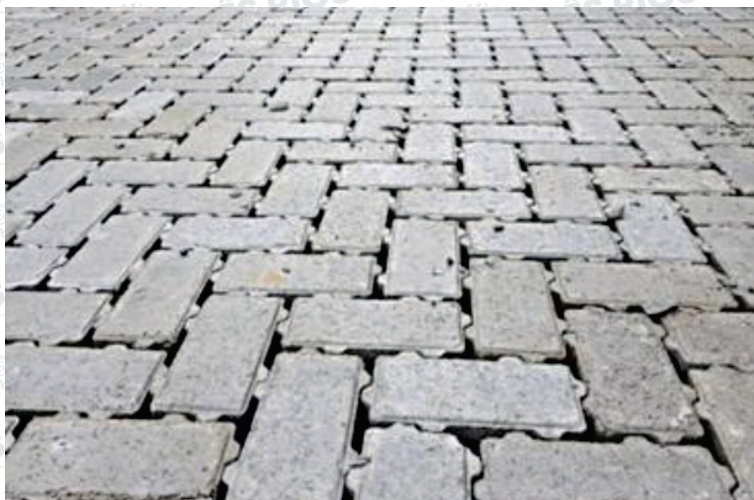
Figura 61. Modelo de Pavimento Impermeável
