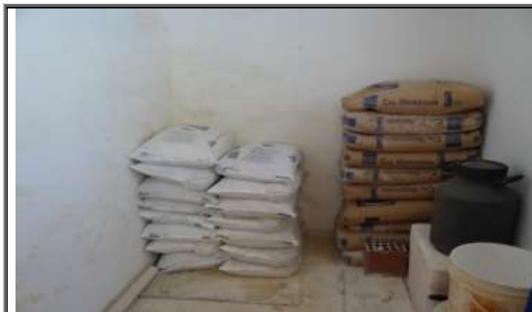
Figura 153 – Abrigo para cal e sulfato de alumínio. Sistema de Abastecimento de Água Moura Brasil.
