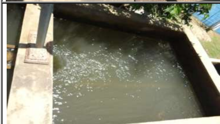
Figura 149 – Filtro. Sistema de Abastecimento de Água - Moura Brasil.
