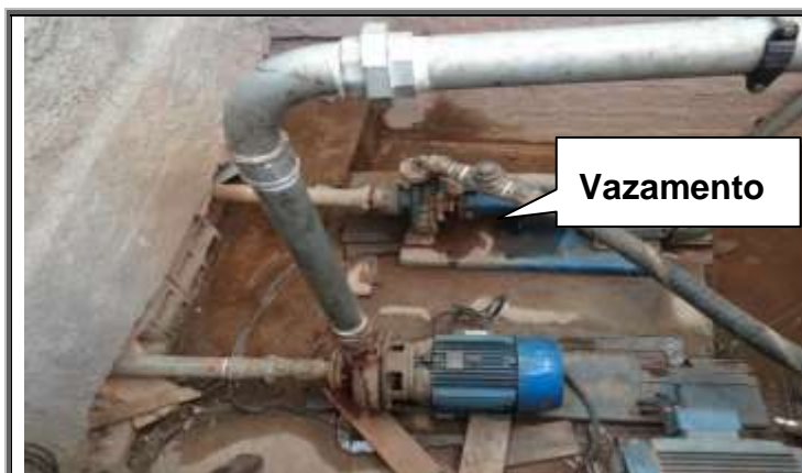
Figura 143 – Vista das instalações no poço seco da captação superficial de água no Rio Piabanha. Sistema de Abastecimento de Água Moura Brasil.
