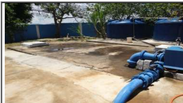
Figura 156 – Reservatório enterrado. Sistema de Abastecimento de Água Moura Brasil.
