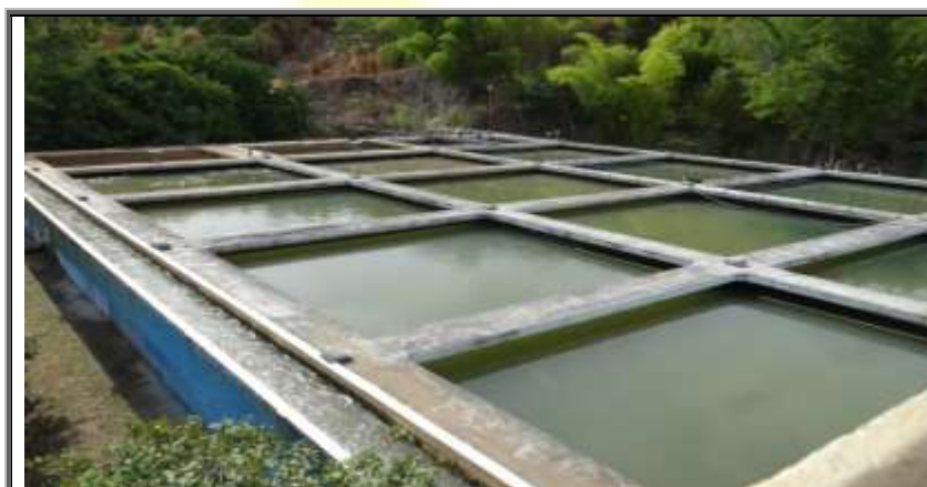
Figura 77 – Vista geral da ETA Cantagalo.
