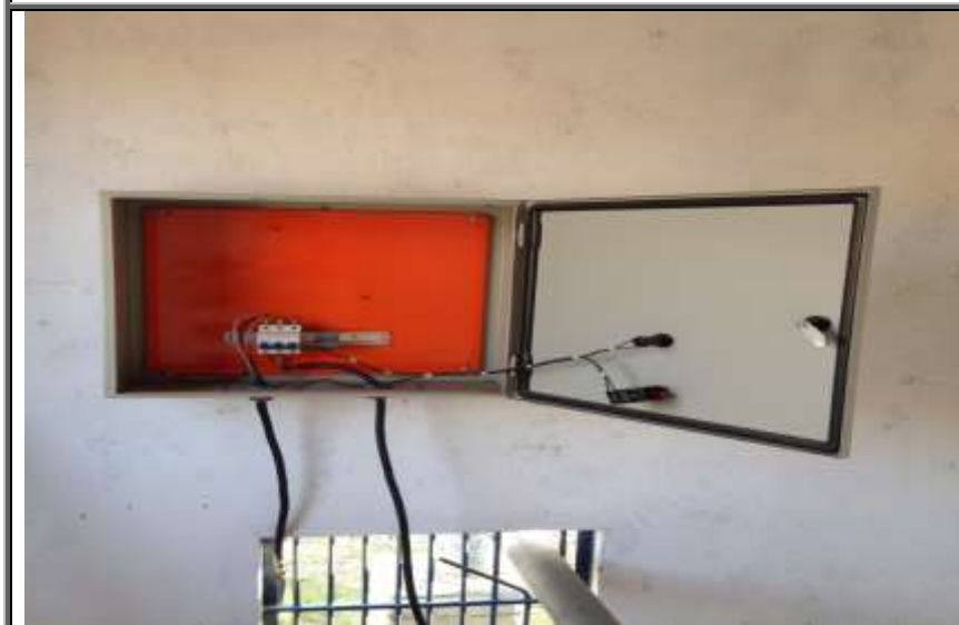
Figura 108 – Painel da Estação Elevatória Habitat
