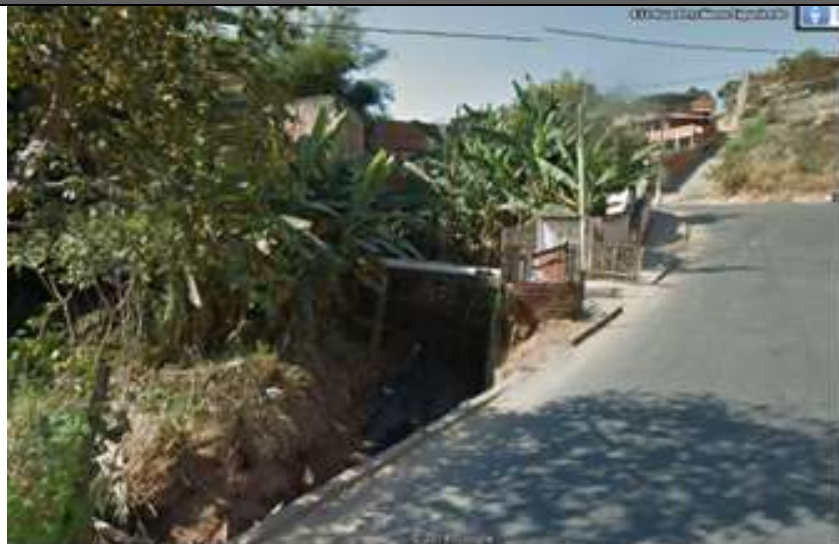
Figura 43 - Trecho retificado com interferências de edificações.
