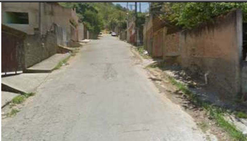
Figura 55 - Rua São José. Inexistência de guias e sarjetas para direcionamento das águas pluviais.
