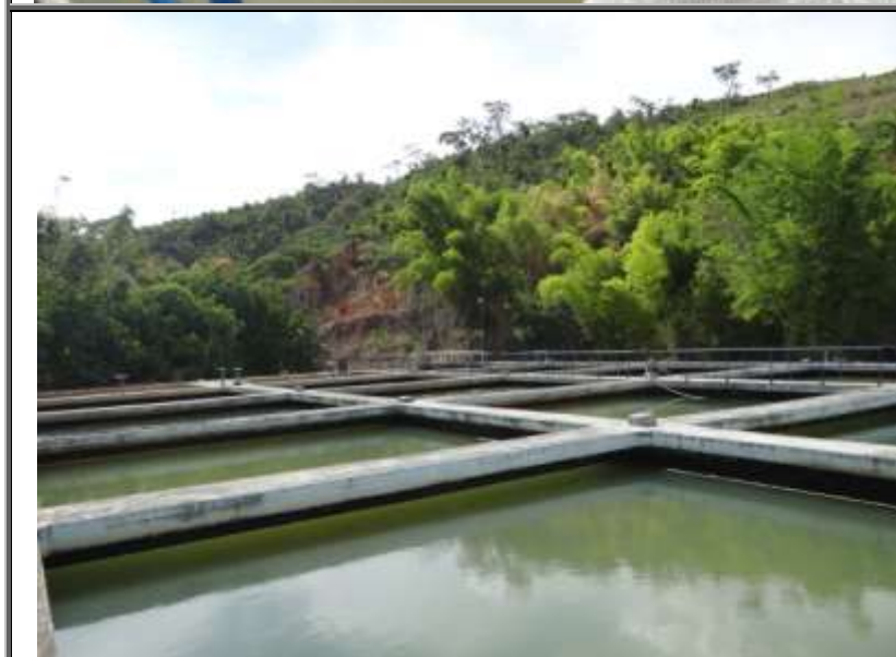
Figura 82 – Vista dos decantadores.
