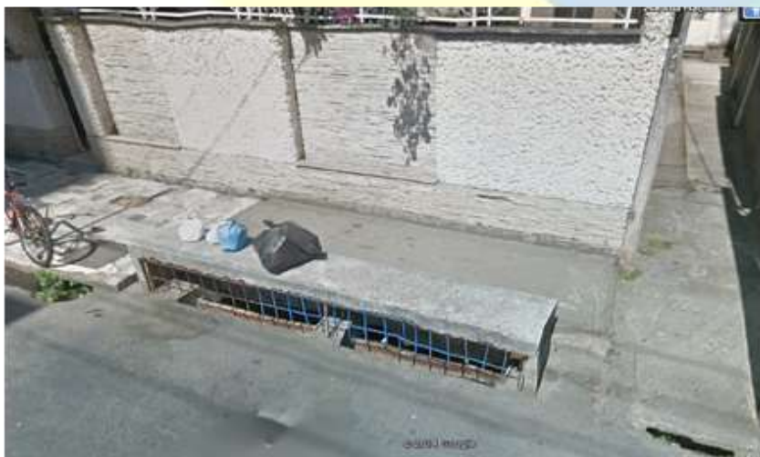
Figura 33 - Rua Maçonaria. Vista à jusante da travessia. Segue com canalização fechada a partir deste ponto
