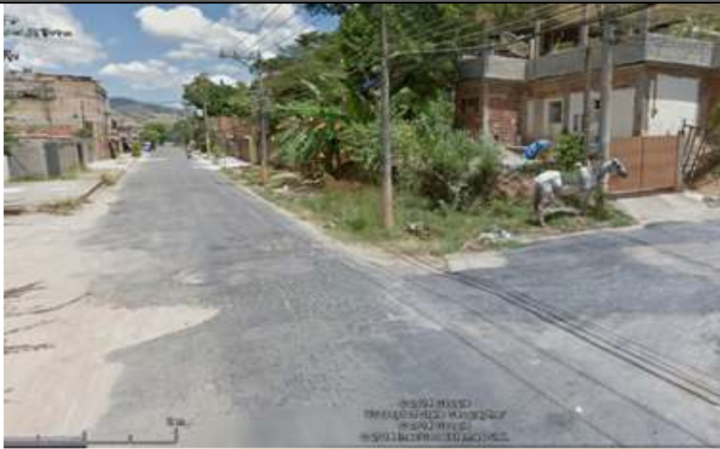
Figura 53 - Inexistência de guias e sarjetas, além de bocas-de-lobo.
