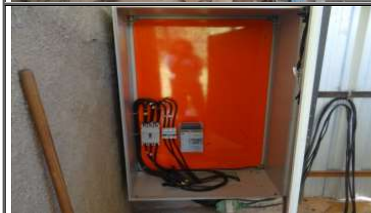
Figura 144 – Quadro de comando elétrico da captação superficial de água no Rio Piabanha. Sistema de Abastecimento de Água Moura Brasil.
