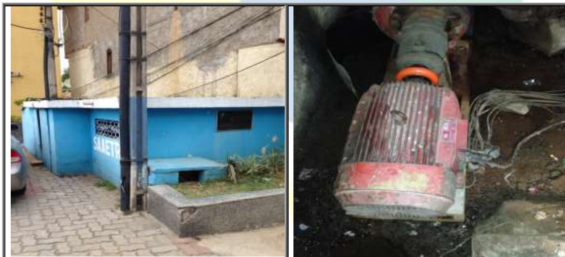
Figura 111 – Estação Elevatória Delegacia
