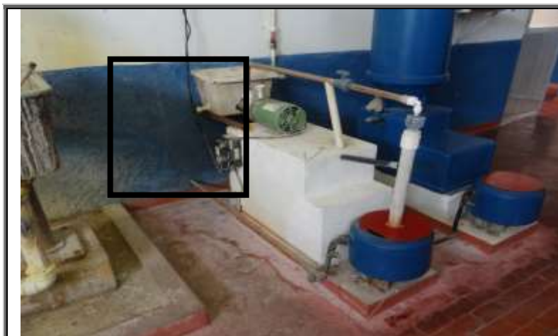
Figura 97 – Bomba dosadora
