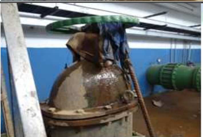
Figura 72 – Detalhe de vazamento em registro em tubulação no poço/casa de bombas do sistema de captação de água no Rio Paraíba do Sul, Sistema de Abastecimento de Água Cantagalo.
