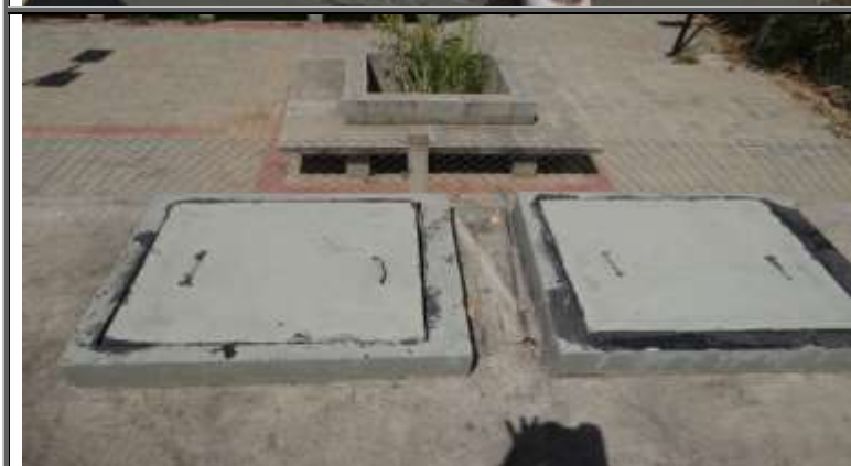
Figura 188 – Unidades anaeróbias de tratamento da ETE Km 21
