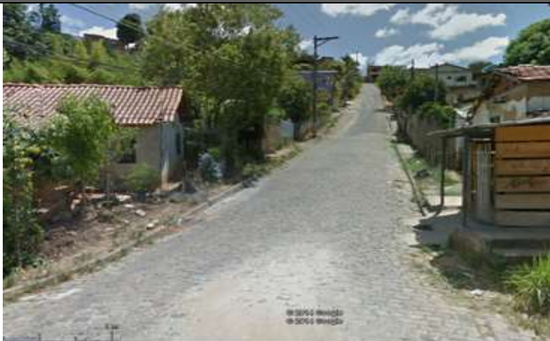
Figura 54 - Travessa São José. Inexistência de boca-de-lobo, em longa extensão de via declivosa.
