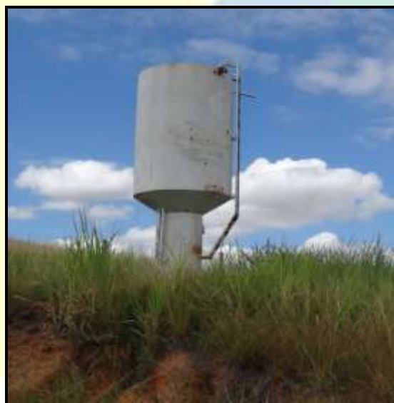
Figura 179 – Reservatório do Sistema de Abastecimento de Água dos bairros Hermogênio Silva e Gibatão .
