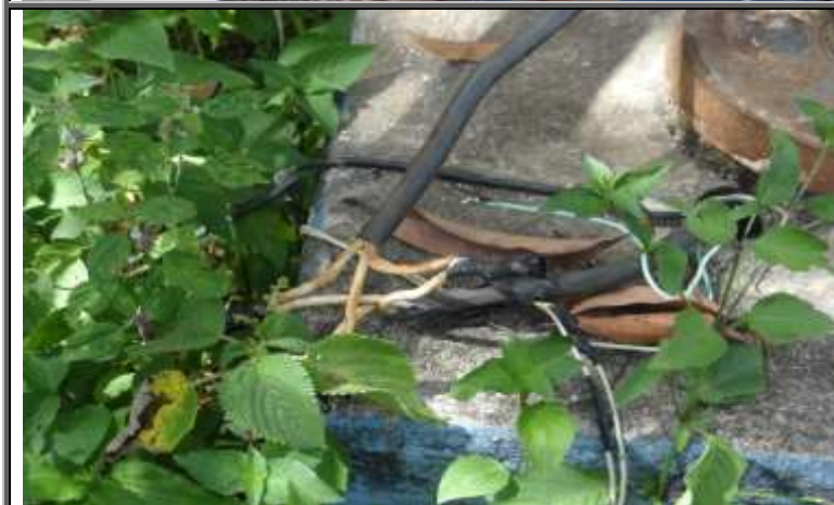
Figura 178 – Detalhes da fiação elétrica do poço do sistema de abastecimento de água dos bairros Hermogênio Silva e Gibatão
