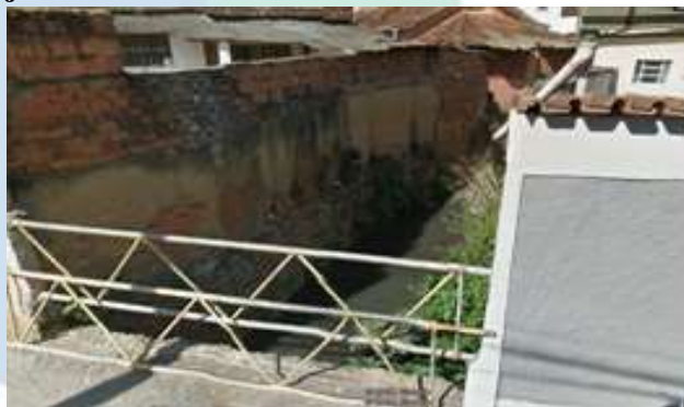
Figura 37 - Rua Marta Ank. Vista das condições à jusante da travessia.
