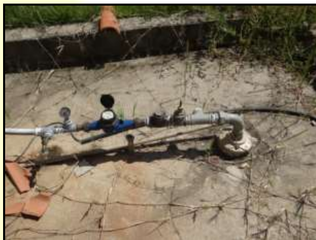
Figura 182– Poço do sistema de abastecimento de água do Km 21
