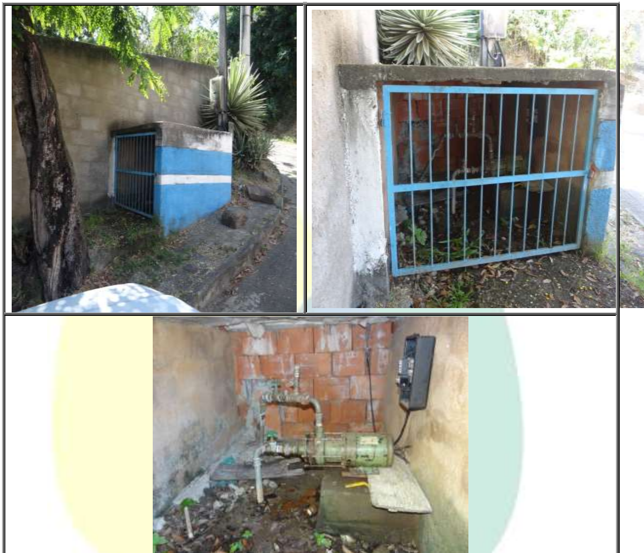
Figura 133 – Estação Elevatória Diacuí
