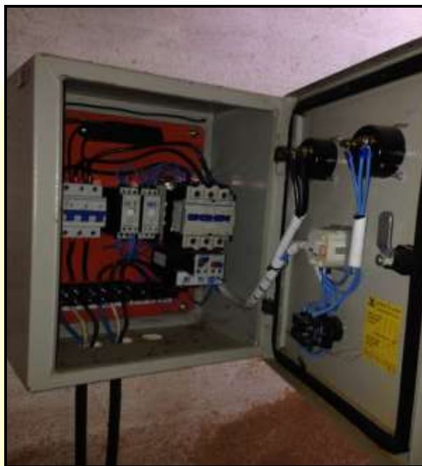
Figura 123 – Painel da Estação Elevatória Barão Ribeiro de Sá
