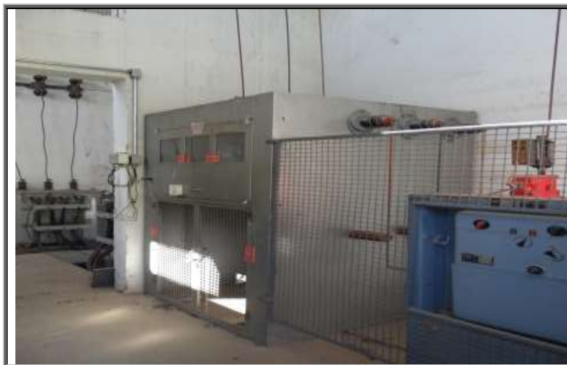
Figura 75 – Subestação elétrica (instalações) do sistema de abastecimento de água Cantagalo.
