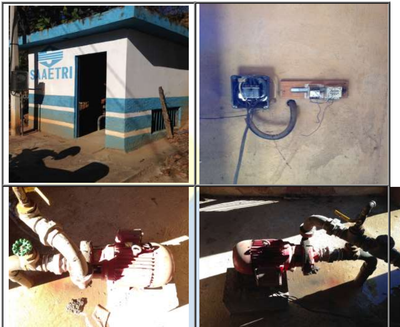
Figura 130 – Estação Elevatória Fábrica de Talco
