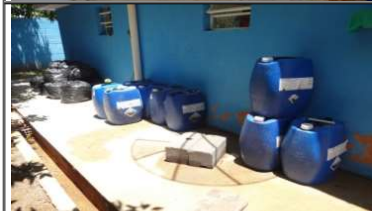
Figura 154 – Armazenamento de hipoclorito de sódio. Sistema de Abastecimento de Água Moura Brasil.
