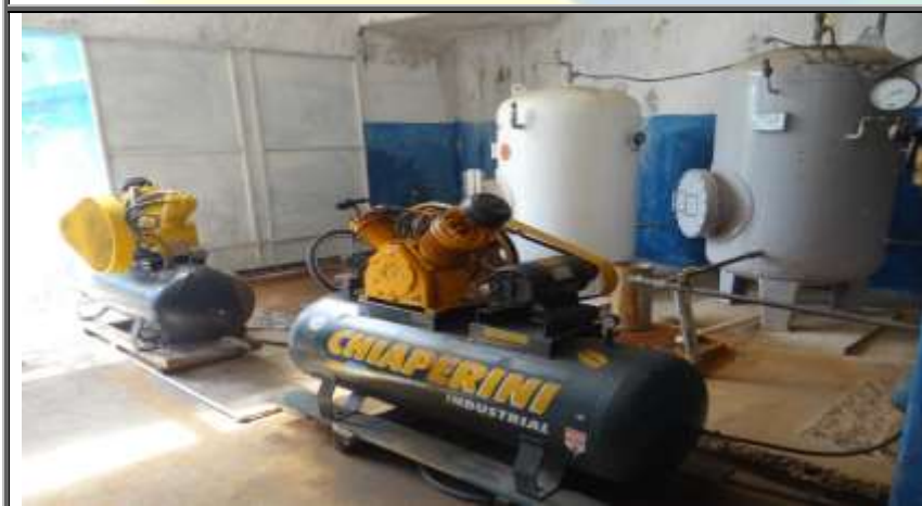
Figura 91 – Compressores de ar utilizados para lavagem dos filtros
