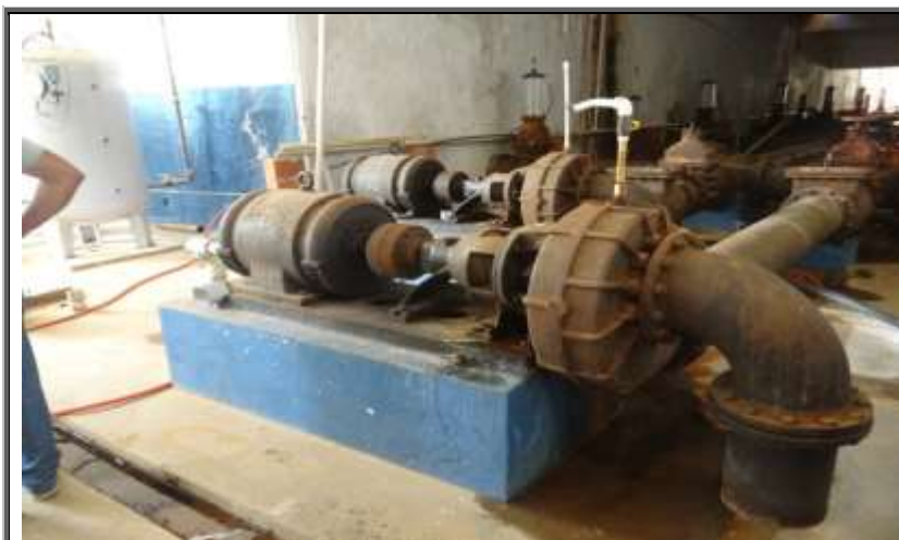
Figura 89 – Bombas utilizadas na operação de lavagem dos filtros.
