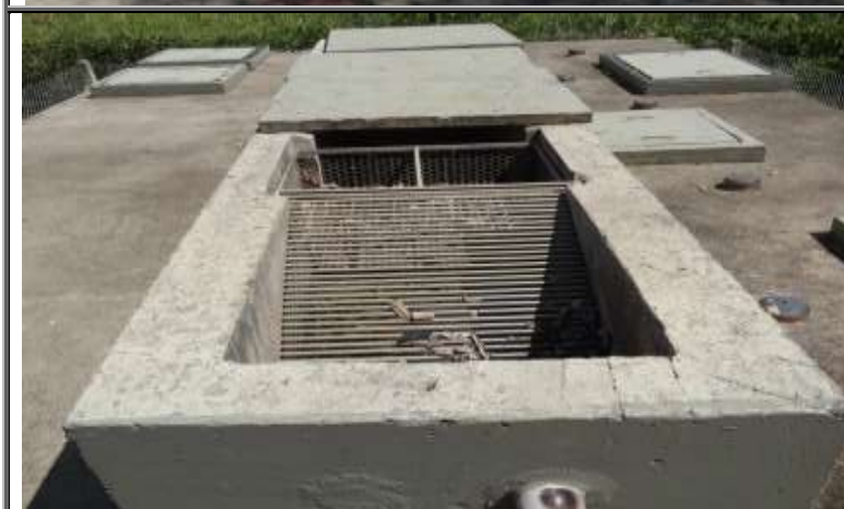
Figura 187 – tratamento preliminar da ETE Km 21
