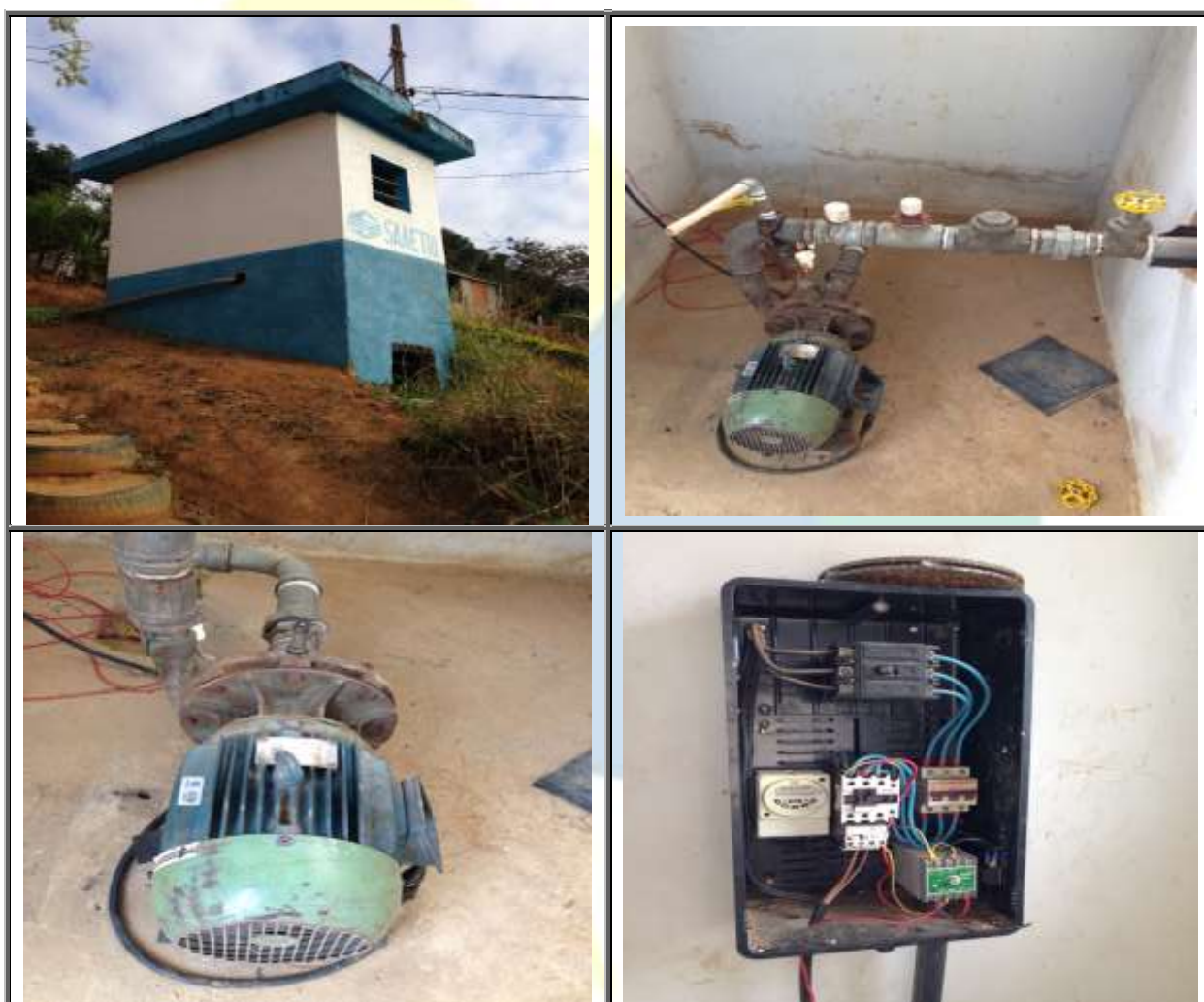
Figura 129 – Estação Elevatória Paraná
