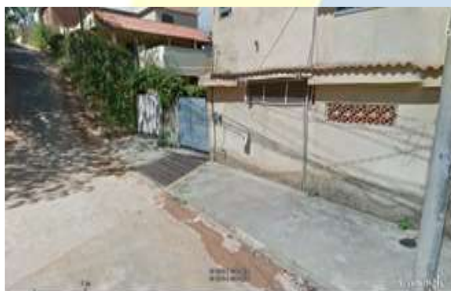
Figura 29 - Rua Teixeira do Rosário. Vista à Jusante da Travessia. Canalização fechada.
