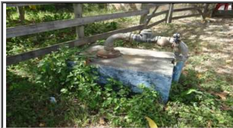
Figura 176 – Poço do sistema de abastecimento de água dos bairros Hermogênio Silva e Gibatão
