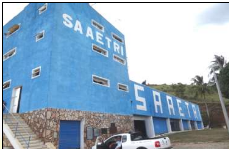
Figura 76 – Prédio da ETA do sistema de abastecimento de água Cantagalo.
