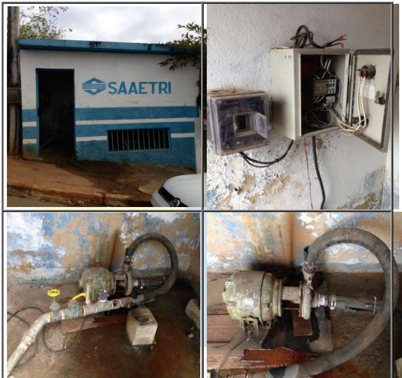
Figura 126 – Estação Elevatória Canhão
