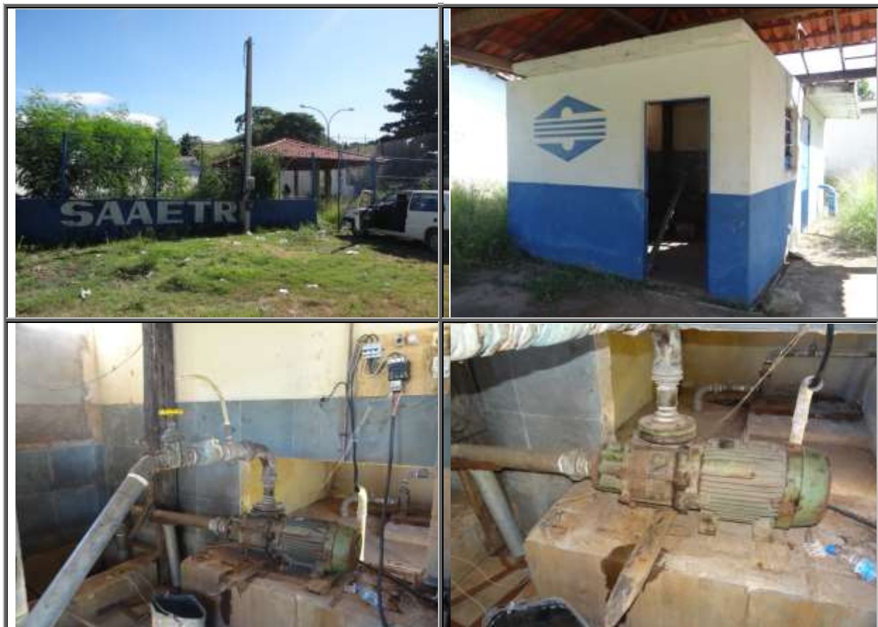
Figura 138 – Estação Elevatória Pilões Praça
