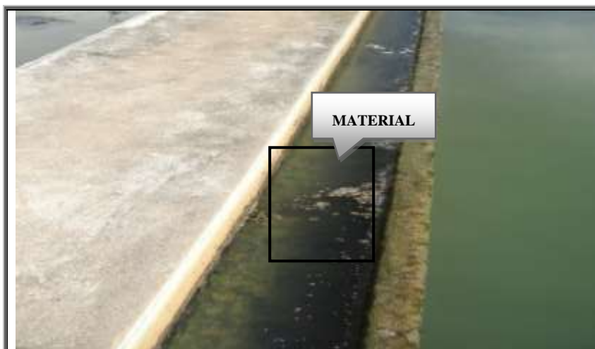
Figura 83 – Calha dos decantadores – detalhe de material flutuante que traspasa o decantador e segue para os filtros.
