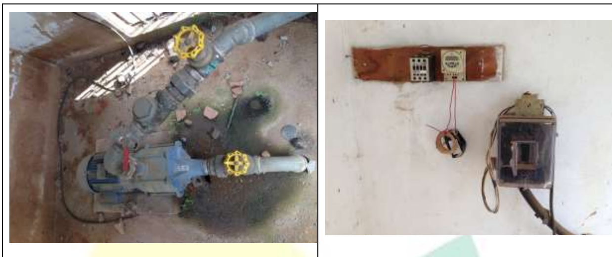
Figura 124 – Estação Elevatória Purys
