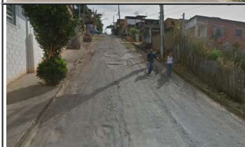
Figura 58 - Rua Virgílio Torno. Alta declividade e ausência de bocas-de-lobo.
