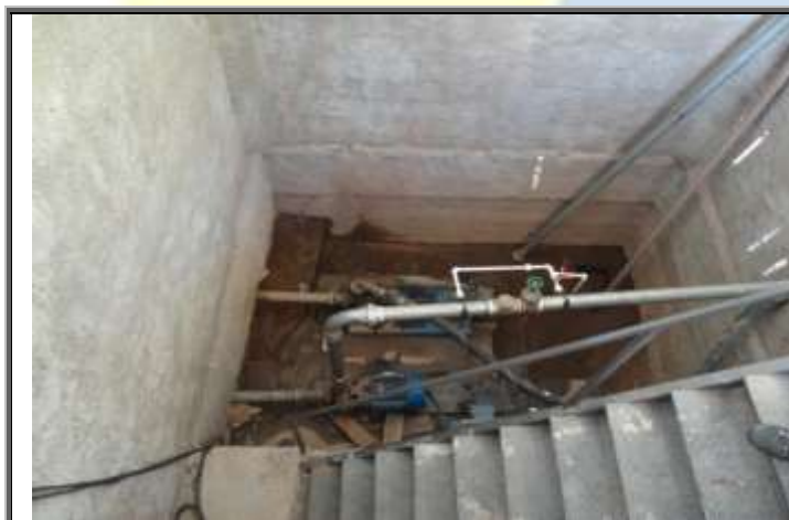
Figura 142 – Vista do poço seco instalado na captação superficial de água no Rio Piabanha. Sistema de Abastecimento de Água Moura Brasil.
