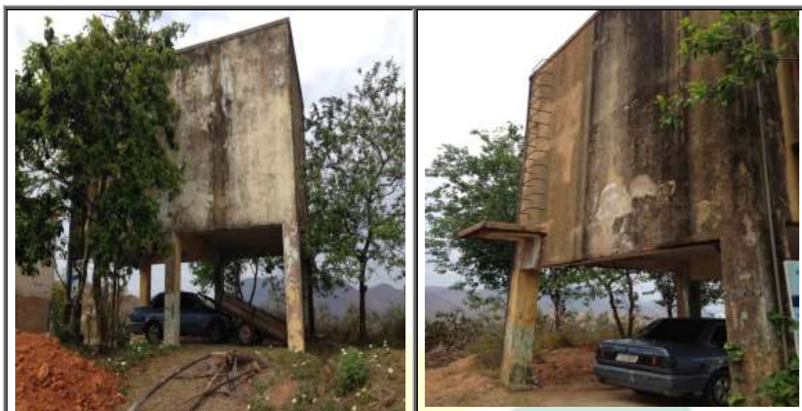
Figura 106 – Reservatório elevado II
