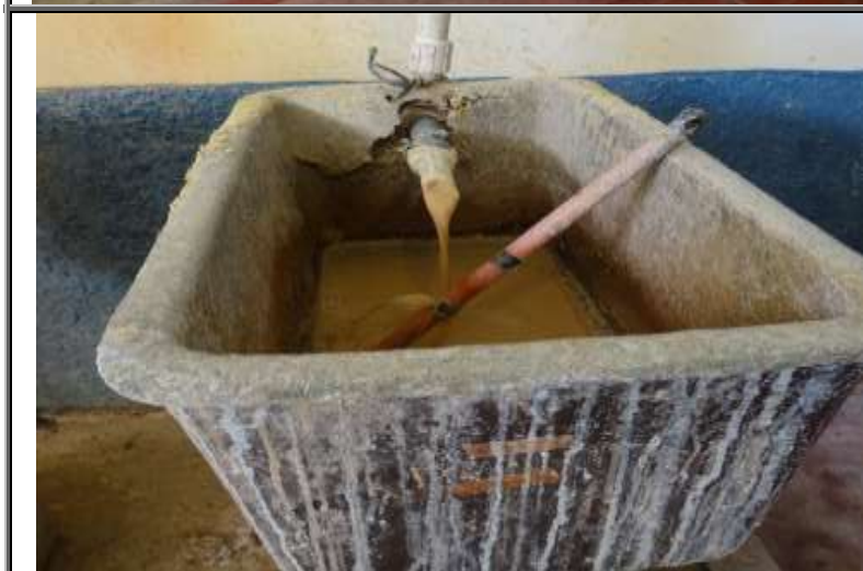
Figura 98 – Detalhe do dosador
