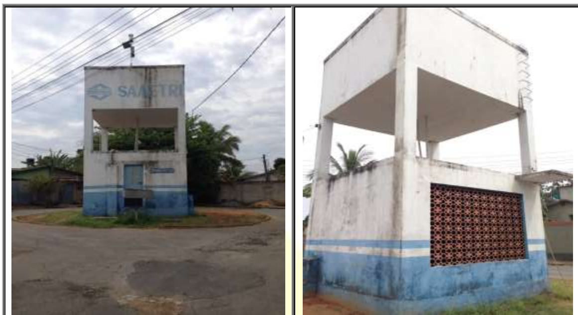
Figura 105 – Reservatório elevado I
