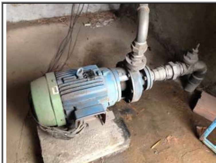
Figura 120 - Estação Elevatória Boa União
