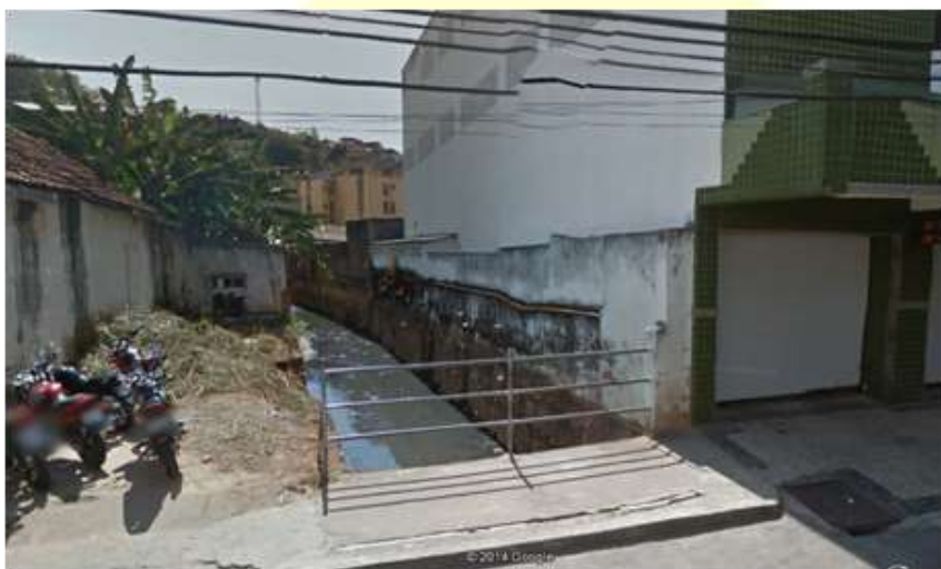
Figura 32 - Rua Maçonaria. Vista à montante da Travessia. Córrego retificado e canalizado.
