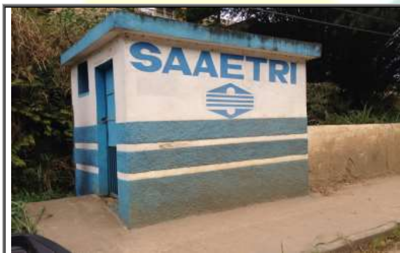
Figura 117 – Estação Elevatória Boa União
