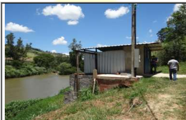
Figura 140 – Vista das instalações para Captação superficial de água no Rio Piabanha. Sistema de Abastecimento de Água Moura Brasil.
