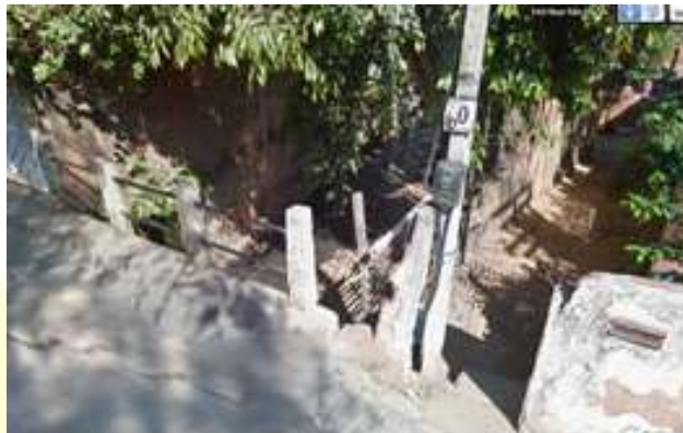
Figura 35 - Rua São Lucas. Vista à jusante da Travessia. Córrego retificado e canalizado.
