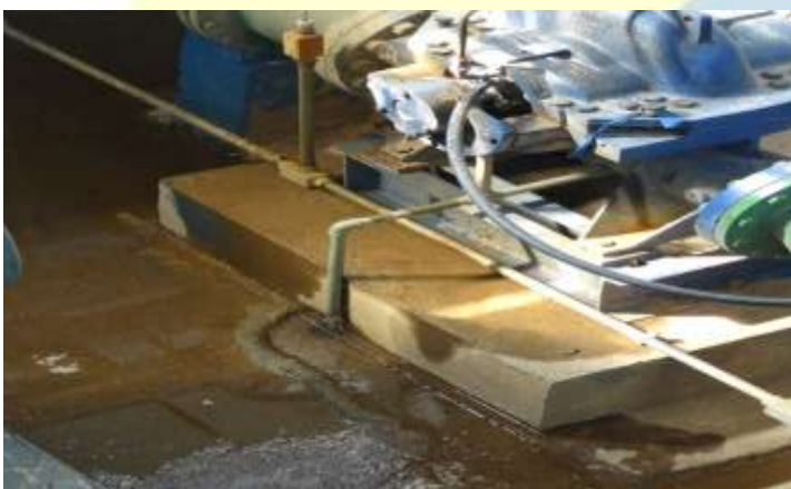
Figura 71 – Detalhe do piso com presença de água advinda de vazamentos nas peças instaladas no poço/casa de bombas do sistema de abastecimento de água Cantagalo.
