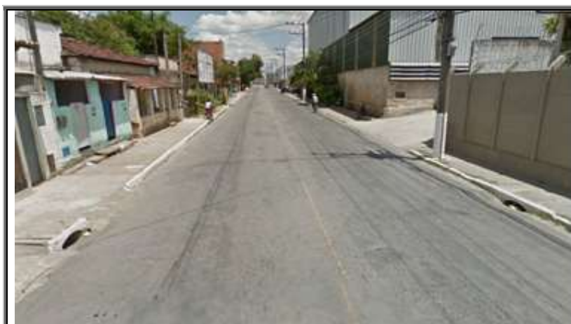
Figura 56 - Rua Isaltino Silveira. Trecho com boca-de-lobo em ponto baixo.
