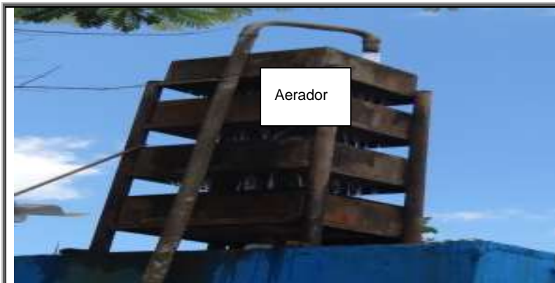
Figura 163 - Aerador de tabuleiro
