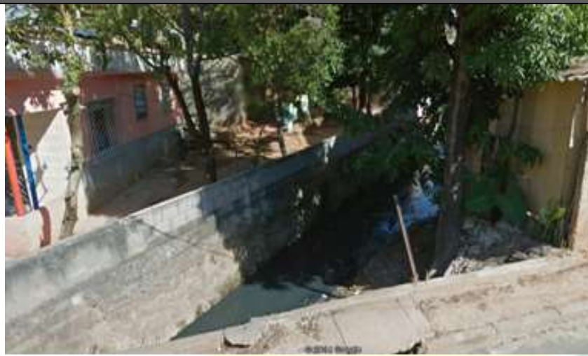
Figura 42 - Córrego retificado e canalizado. Nítida evidência de lançamentos de efluentes domésticos
