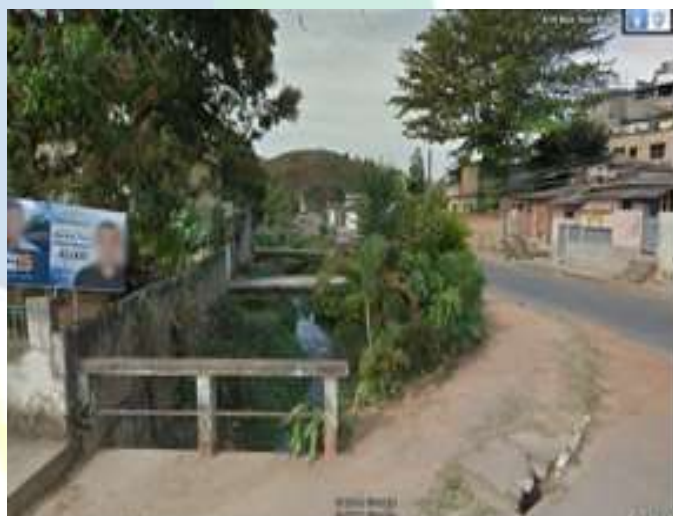
Figura 24 - Nota-se o curso d'água retificado, canalizado e sob diversas travessias.
