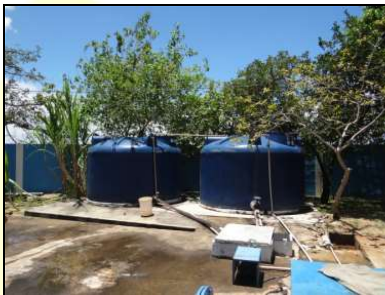
Figura 155 – Reservatório de soluções de sulfato de alumínio, cal e cloro. Sistema de Abastecimento de Água Moura Brasil.
