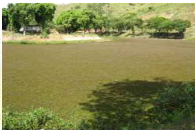
Figura 39 - Vista da Bacia de amortecimento de cheias.
