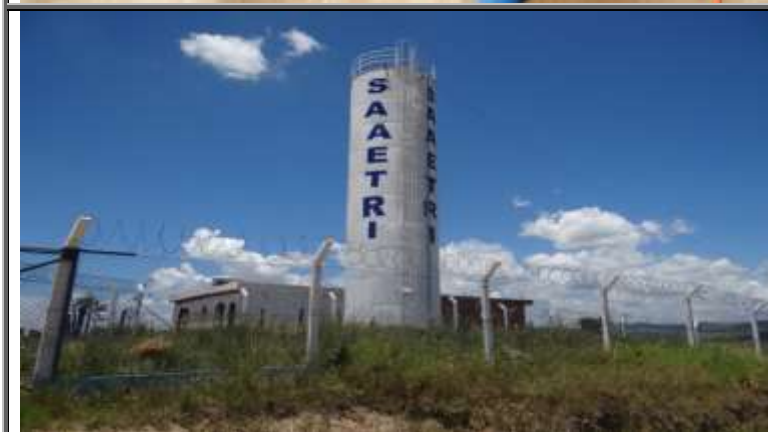
Figura 157 – Reservatório elevado. Sistema de Abastecimento de Água Moura Brasil.
