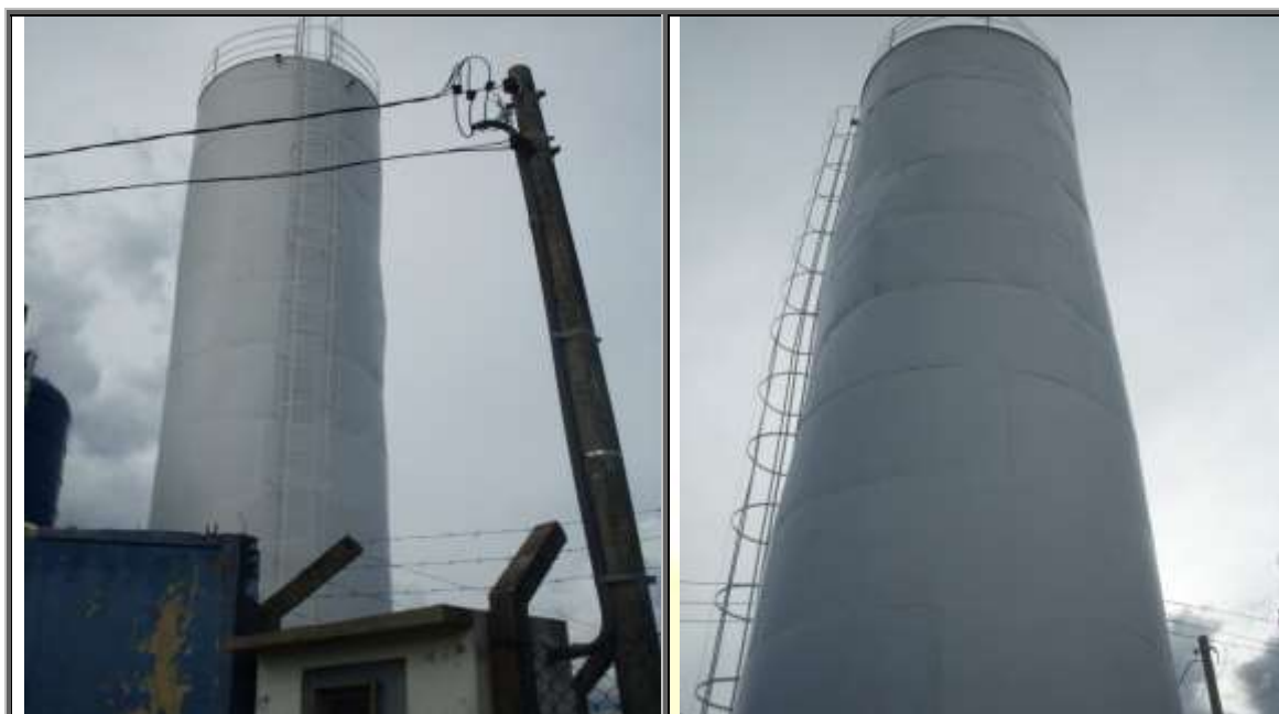
Figura 102 – Reservatório apoiado – CTB
