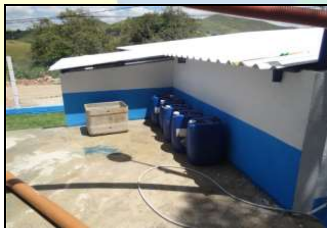
Figura 170 – Armazenamento de hipoclorito de sódio
