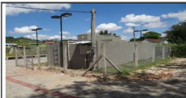
Figura 186 – vista geral da ETE Km 21
