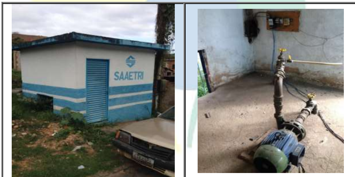
Figura 114 – Estação Elevatória Cidade Nova
