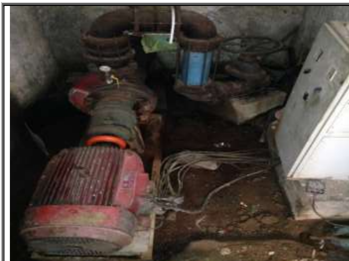
Figura 112 – Bomba da Estação Elevatória Delegacia
