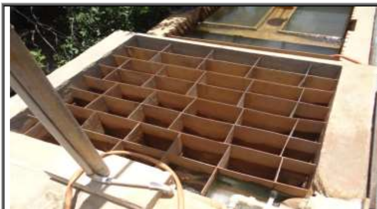
Figura 147 – Unidade de flocculação. Sistema de Abastecimento de Água - Moura Brasil
