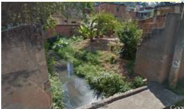
Figura 36 - Rua Marta Ank. Vista das condições à montante da travessia
