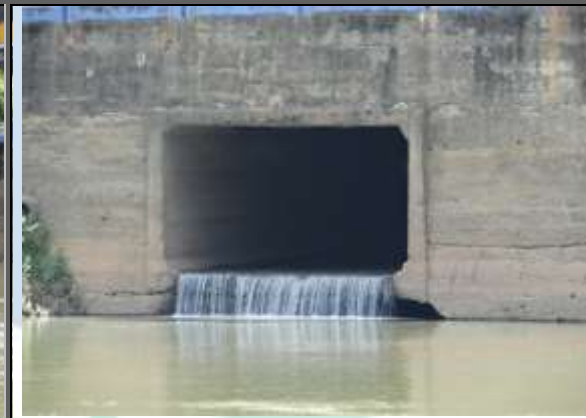
Figura 185 - lançamento de esgoto in natura no Rio Paraíba do Sul.
