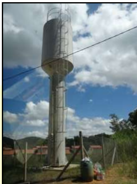
Figura 183– Reservatório do Sistema de Abastecimento de Água do Km 21.
