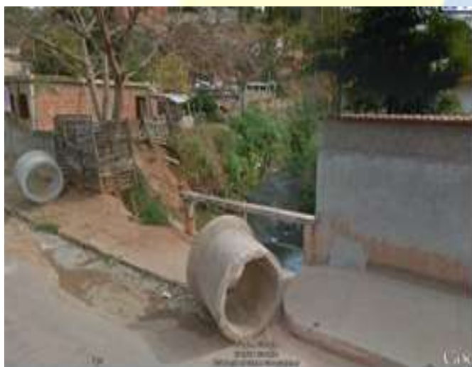
Figura 23 - Situação à montante da travessia. Nota-se edificações em faixa de inundação
