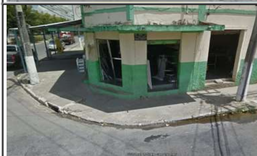
Figura 52 - Vista de uma boca-de-lobo e a montante um empozamento de água. Falta de declividade longitudinal.
