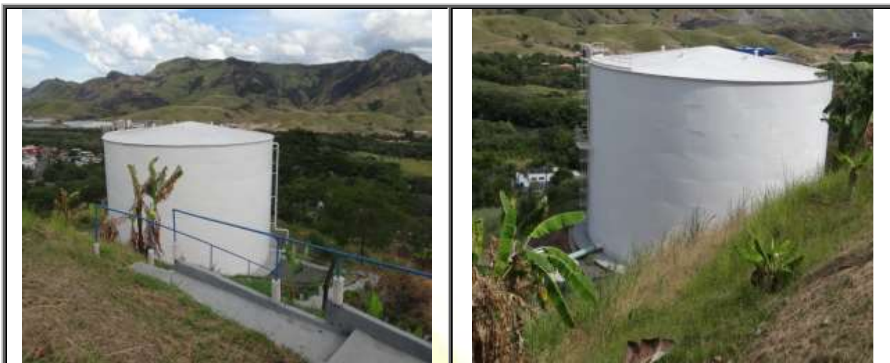
Figura 100 – Reservatório apoiado – Eta Cantagalo
