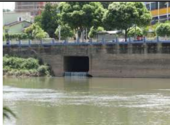
Figura 185 - lançamento de esgoto in natura no Rio Paraíba do Sul.
