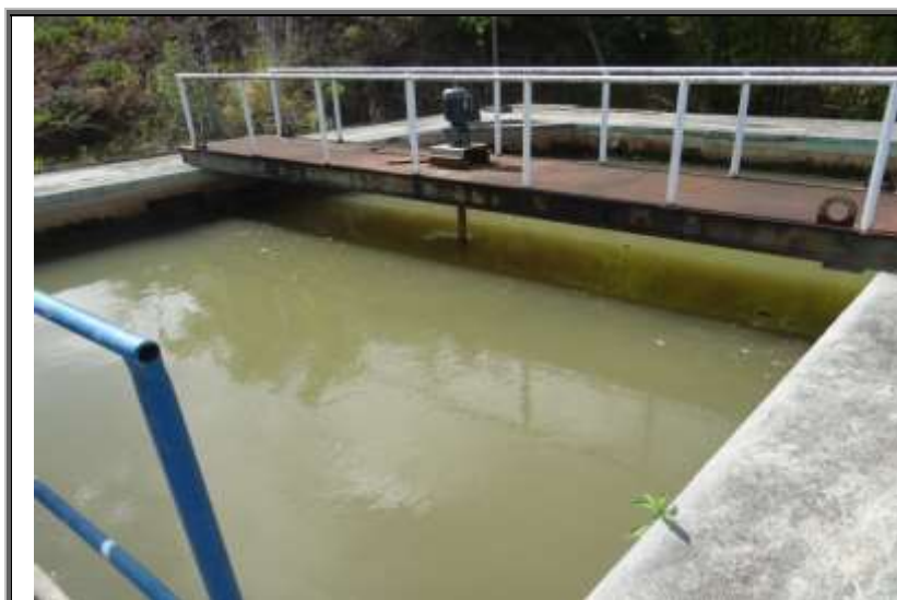
Figura 81 – Floculador mecânico.
