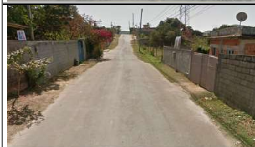
Figura 57 - Rua Presidente João Goulart. Inexistência de guias, sarjetas e bocas-de-lobo.
