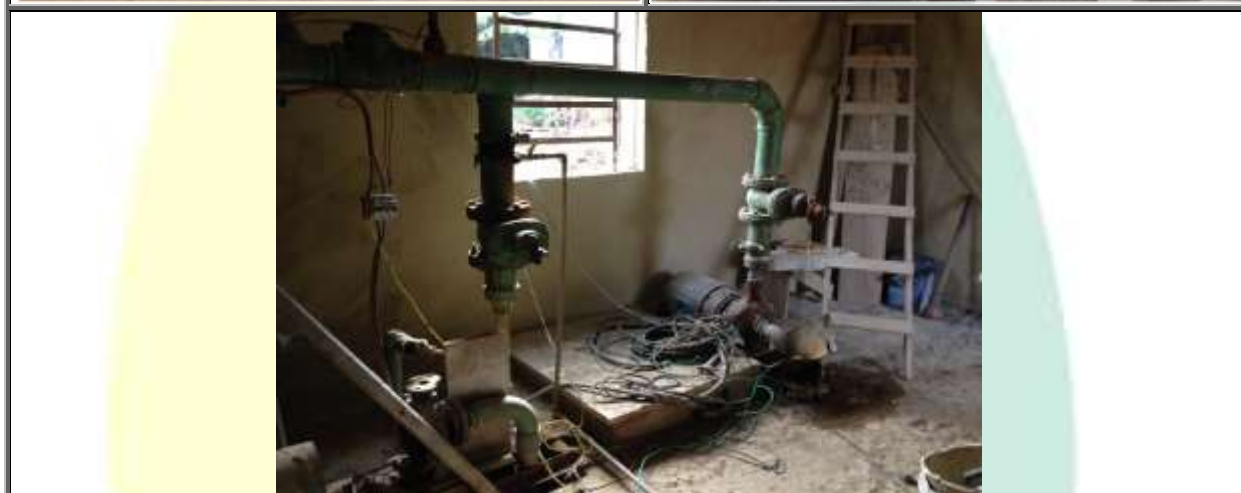
Figura 125 – Estação Elevatória Purys Cisterna
