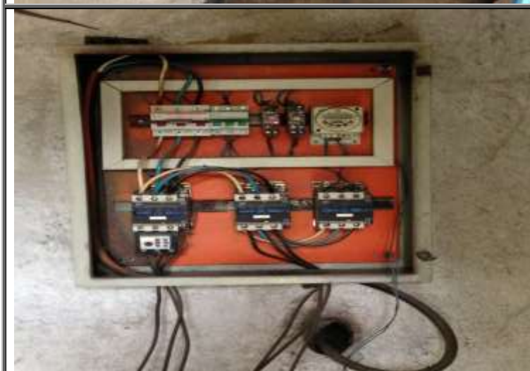
Figura 119 – Painel da Estação Elevatória Boa União
