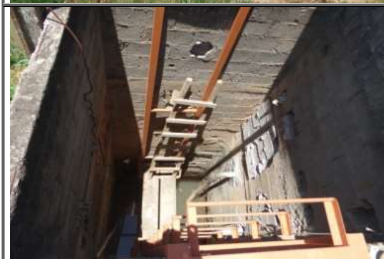
Figura 141 – Torre de Captação superficial de água no Rio Piabanha. Sistema de Abastecimento de Água Moura Brasil.
