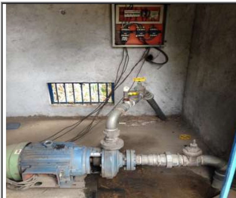
Figura 118 – Estação Elevatória Boa União
