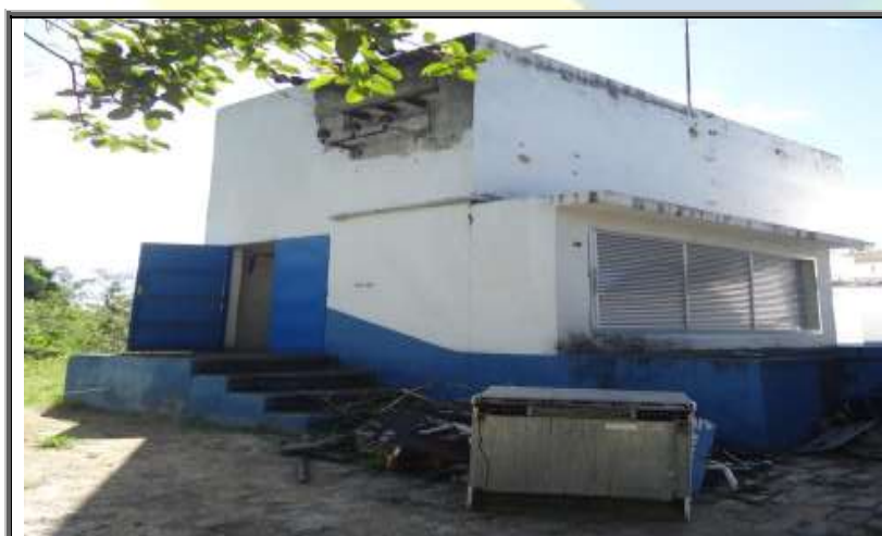
Figura 74 – Subestação elétrica (abrigo) do sistema de abastecimento de água Cantagalo.
