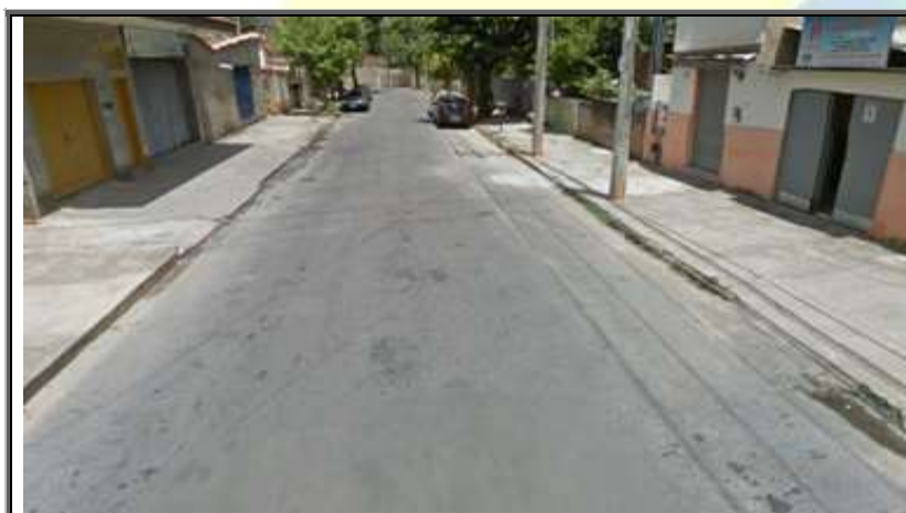
Figura 51 - Rua Iglesias Lopes. Sistema de microdrenagem irregular.
