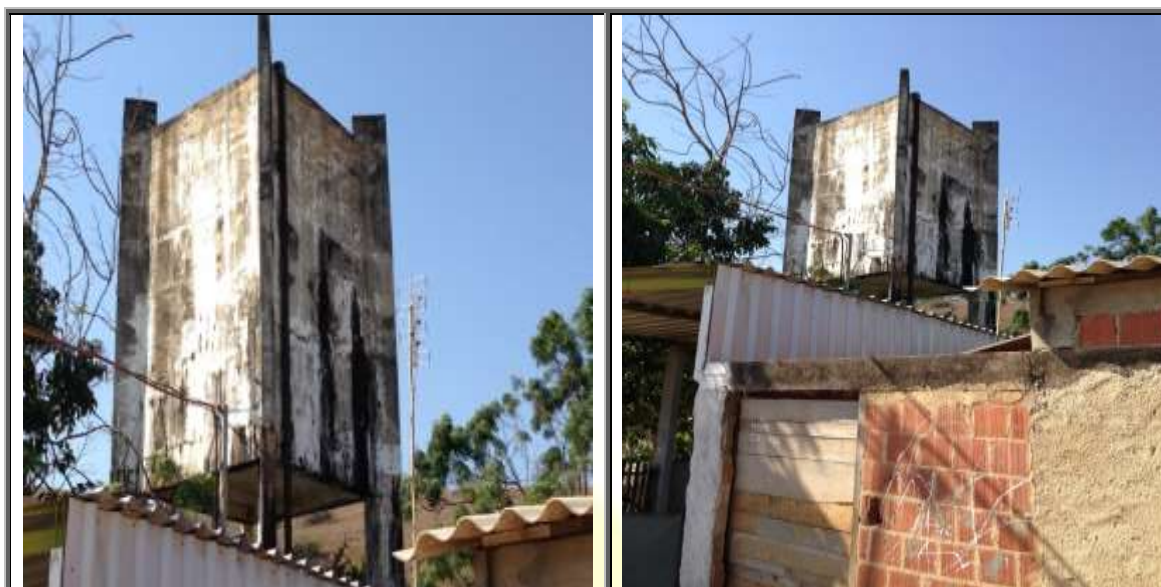
Figura 103 – Reservatório elevado – Purys
