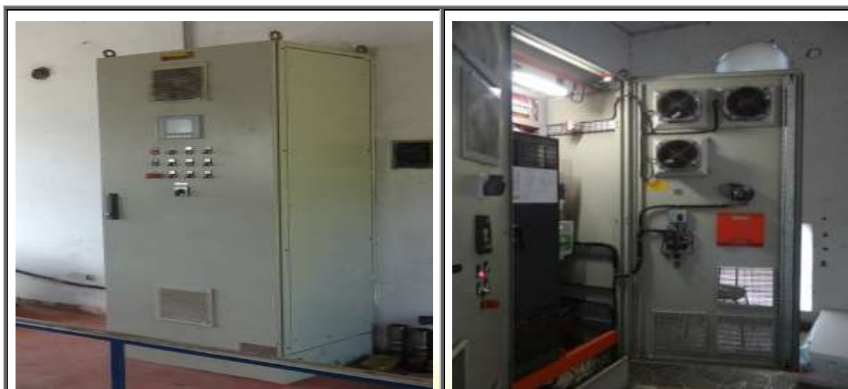
Figura 73 – Quadro elétrico do poço/casa de bombas do sistema de abastecimento de água Cantagalo.
