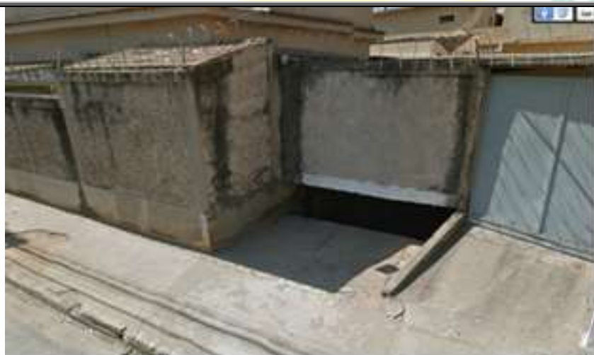
Figura 44 - Rua Joaquim Pinto Portela. Vista à montante da travessia. Nota-se a canalização construída sob a edificação.
