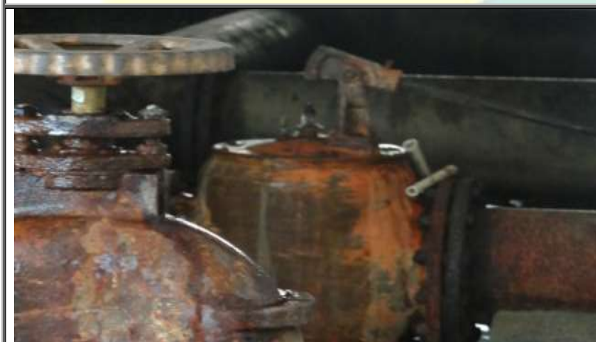
Figura 90 – Bombas utilizadas na operação de lavagem dos filtros – detalhes de vazamentos e infiltrações.
