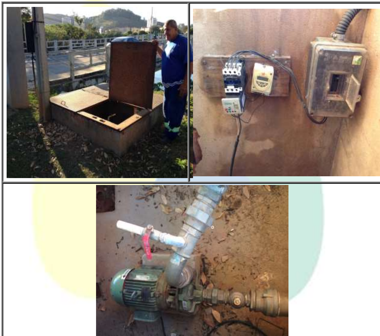
Figura 132 – Estação Elevatória Ponte do SESI
