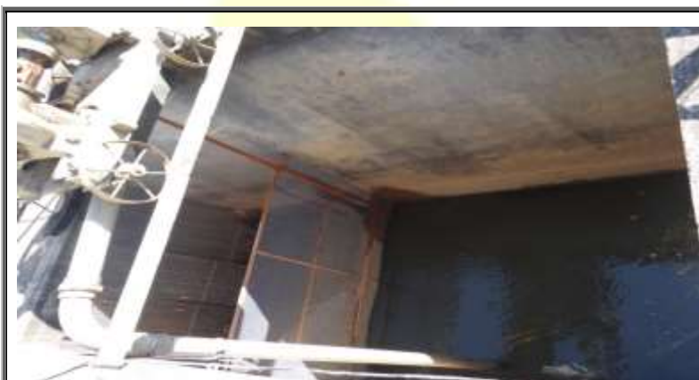
Figura 68 – Gradeamento da captação do sistema de abastecimento de água Cantagalo.
