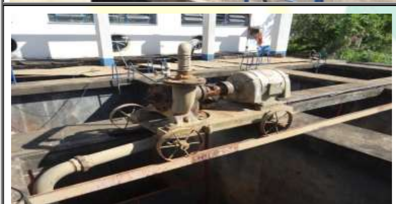
Figura 69 – Bombas de esgotamento de areia da caixas de areia da captação do sistema de abastecimento de água Cantagalo.
