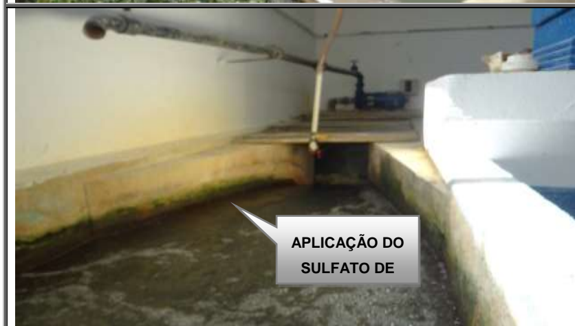
Figura 78 – Calha Parshall.
