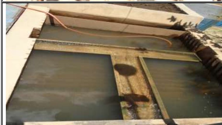
Figura 148 – Decantador de alta taxa. Sistema de Abastecimento de Água Moura Brasil.
