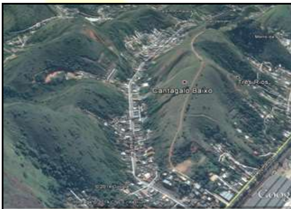
Figura 27 - Imagem de satélite da sub-bacia do Córrego Cantagalo.
