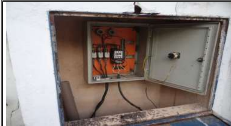
Figura 177 – Quadro elétrico do poço do sistema de abastecimento de água dos bairros Hermogênio Silva e Gibatão
