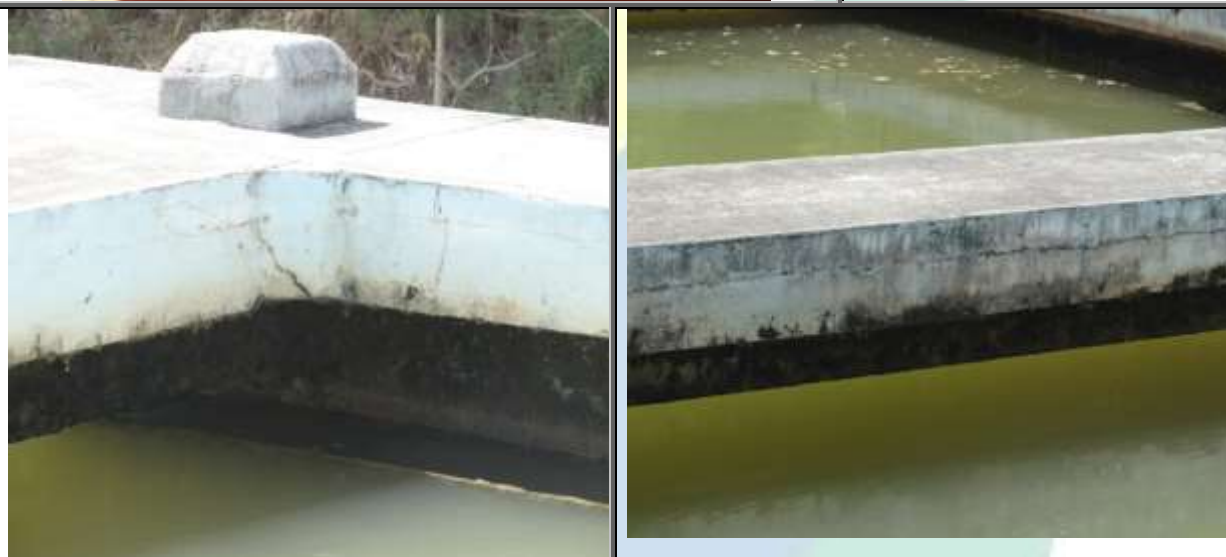
Figura 86 – Detalhe da estrutura civil das passarelas das unidades da ETA Cantagalo (decantação e filtração).
