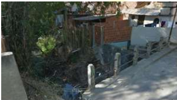
Figura 34 - Rua São Lucas. Vista à montante da Travessia. Vista das interferências às margens do Córrego
