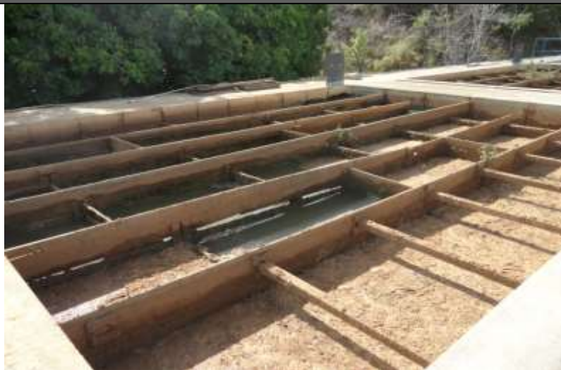
Figura 80 – Vista de um dos floculadores hidráulicos.
