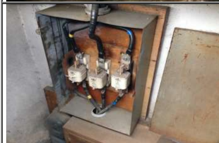
Figura 113 – Painel da Estação Elevatória Delegacia
