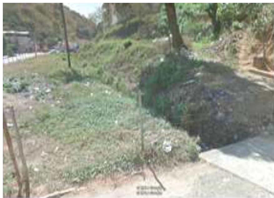
Figura 28 - Rua Teixeira do Rosário. Vista à Montante da Travessia. A imagem apresenta as condições do curso d'água antes de entrar na aduela, esta por sua vez encontra-se subdimensionada. A partir deste trecho o ribeirão encontra-se canalizado.
