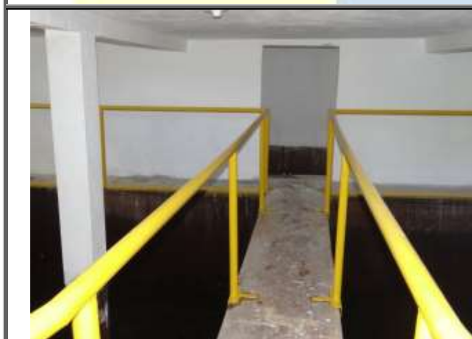
Figura 172 – Reservatório enterrado – detalhe de corrimão com proteção de acesso
