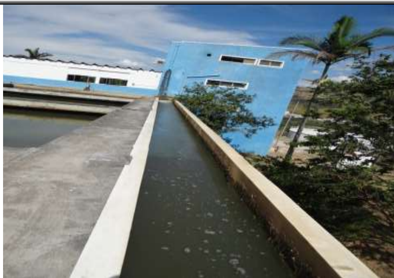
Figura 79 – Canal de água coagulada.
