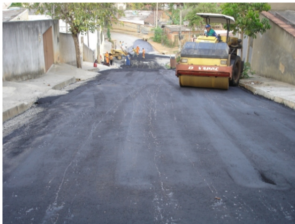
O asfaltamento da Rua Goiás já está em fase final
